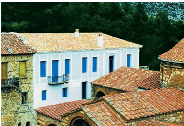
Εικόνα 3. Άποψη της ΒΑ πτέρυγας από ΝΔ, μετά την αποπεράτωση των εργασιών στερέωσης και αποκατάστασης.
