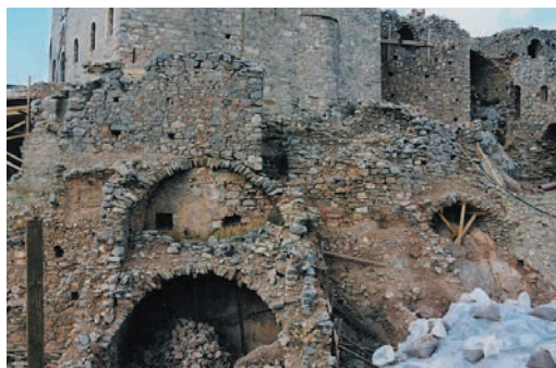
Εικόνα 7. Κατασκευή επάλληλων θόλων.
