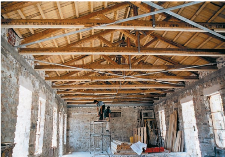
Εικόνα 8. Άποψη του εσωτερικού χώρου του τετάρτου ορόφου μετά την ολοκλήρωση των εργασιών κατασκευής της στέγης. Η οροφογραφία του ΒΑ δωματίου διατηρήθηκε και με την ολοκλήρωση των εργασιών στερεώθηκε και συντηρήθηκε από ειδικευμένο συνεργείο.
