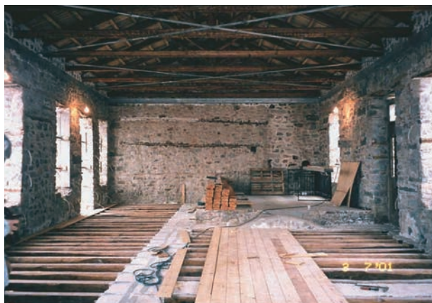
Εικόνα 7. Κατασκευή του ενισχυμένου ξύλινου πατώματος του τετάρτου ορόφου
